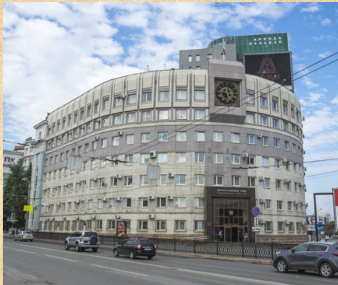
Первое здание Управления ЮУЖД ул. Воровского, 2
