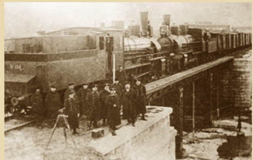
Строительство Транссибирской железной дороги
