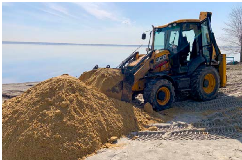
Обустройство пляжа ЧОЦР
