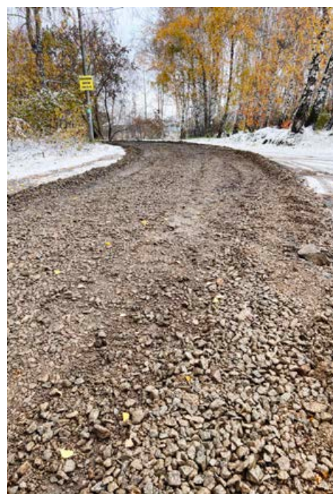
Грейдирование и отсыпка щебня ул. Железнодорожная, п. Исаково
